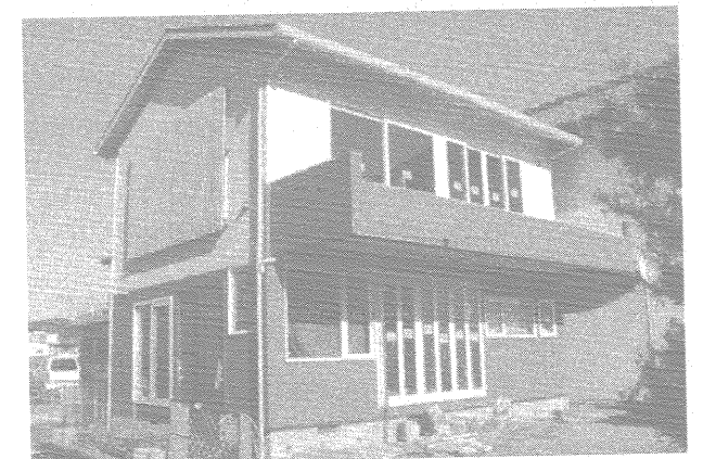
一間持ち出した下部に柱の無いベランダ 桁行方向の1階部分は全開口
